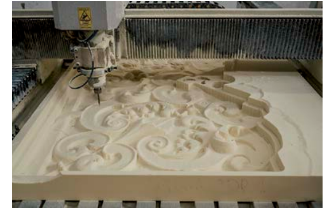
CNC-milling in polyurethane of the yesería ceiling in the Hospital de la Caridad.
