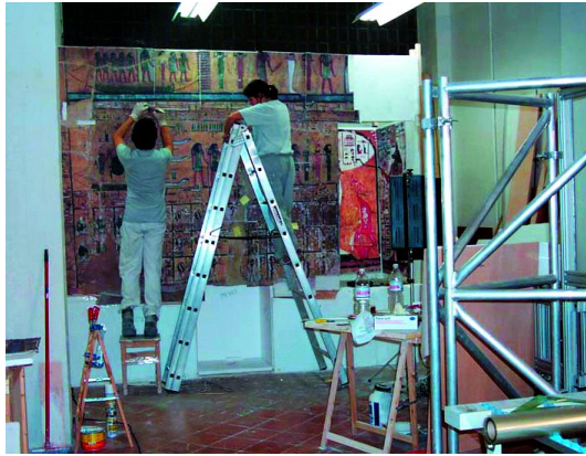
Izquierda: Fijación de las baldosas finales.
